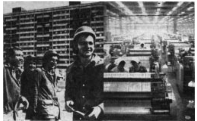
Болгарские и советские строители возводят жилые дома для тружеников газового комплекса в городе Оренбурге, 1979 г.
